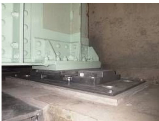
写真4-9 支承取替工
