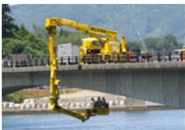
写真2-1 橋梁点検状況
