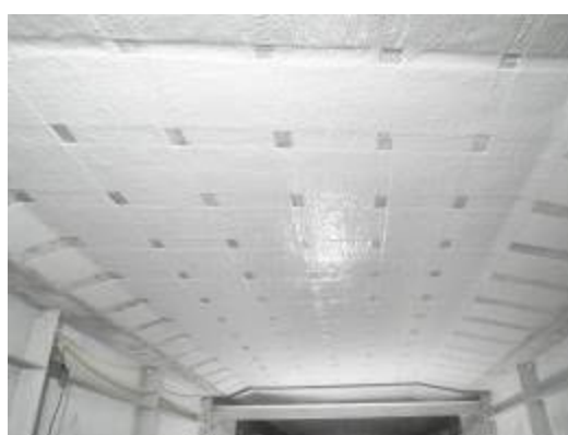
写真4-6 床版補強（炭素繊維シート）
