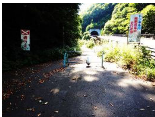
写真4-15 通行止め実施状況
