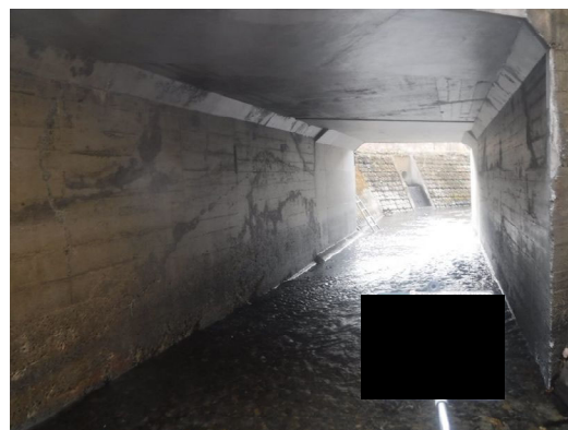
写真4-3 断面補修工
