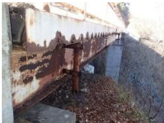
写真4-11 主桁腐食
