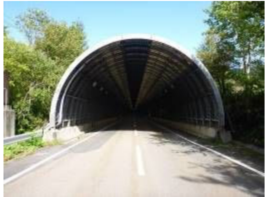
写真4-22 祭時スノーシェルター
