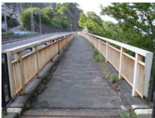
写真4-10 波子舞橋側道橋
