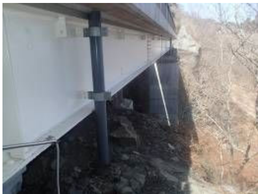
写真4-12 塗替塗装工
