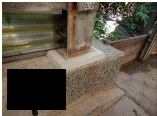
写真4-24 沓座コンクリート補修工
