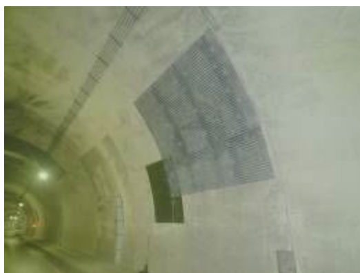
写真4-18 剥落対策工
