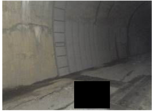
写真4-21 漏水対策工
