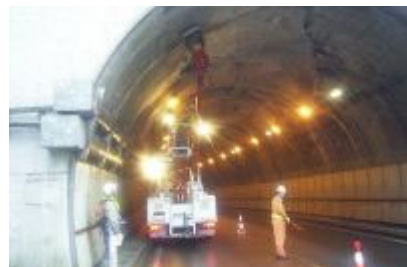
写真2-2 トンネル点検状況
